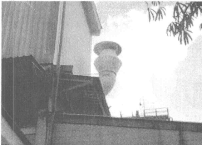
Foto 5. Centro de la foto: Punto de descarga perteneciente al filtro de mangas.
